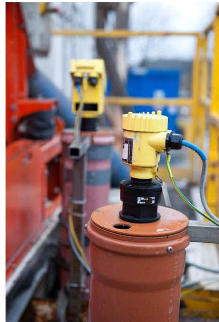
Abb.: 16/17 Tankstandmesssensoren auf der Anlage HH102b
