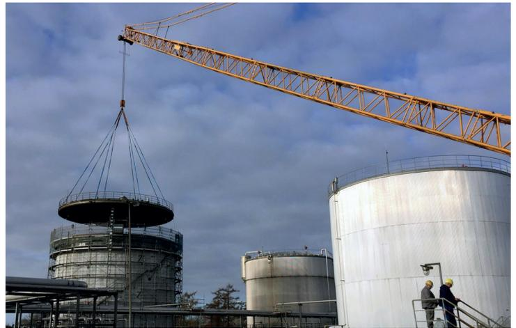
Kranarbeiten zum Austausch eines Reinöltankdaches im ExxonMobil-Betrieb Rühlermoor
