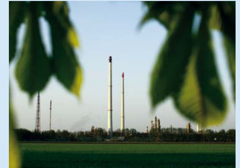
Norddeutsche Erdgasaufbereitungsgesellschaft (NEAG)
