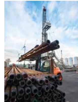
Bild: Vor der Verfüllung wird zuerst die Verrohrung aus dem Boden gezogen
