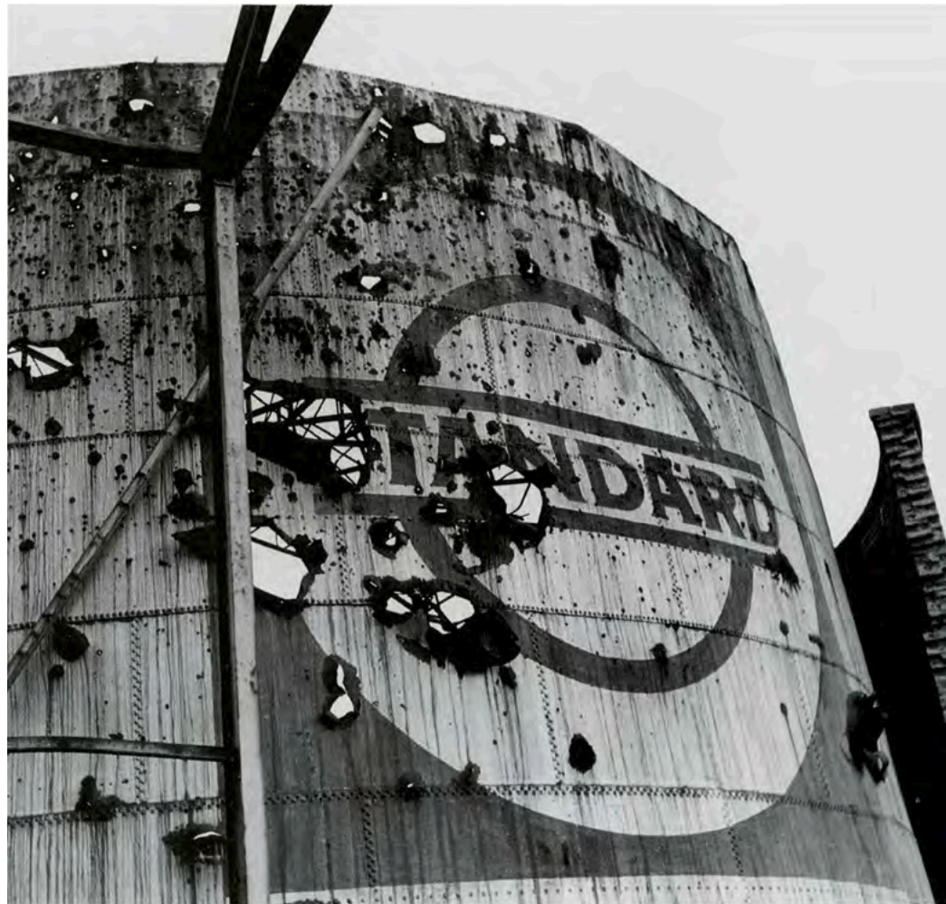
Zerstörter Tank im Neuen Petroleumhafen Hamburg
