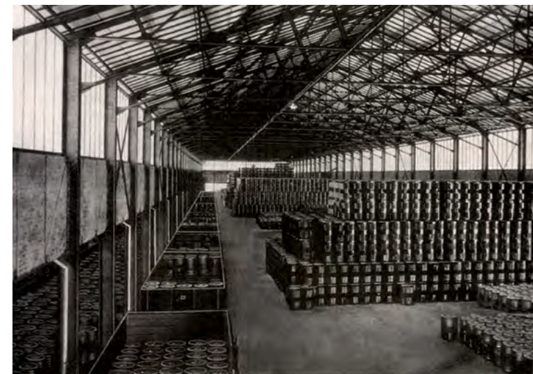
Lagerhalle für Bitumen-Trommeln
