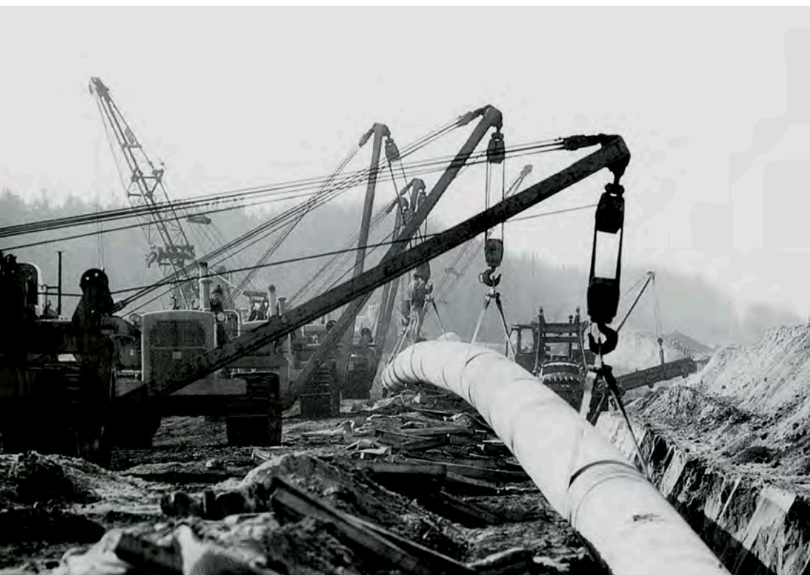
Bau der Rohölleitung von Wilhelmshaven nach Köln - diese Pipeline war die erste große Rohölleitung in der Bundesrepublik
