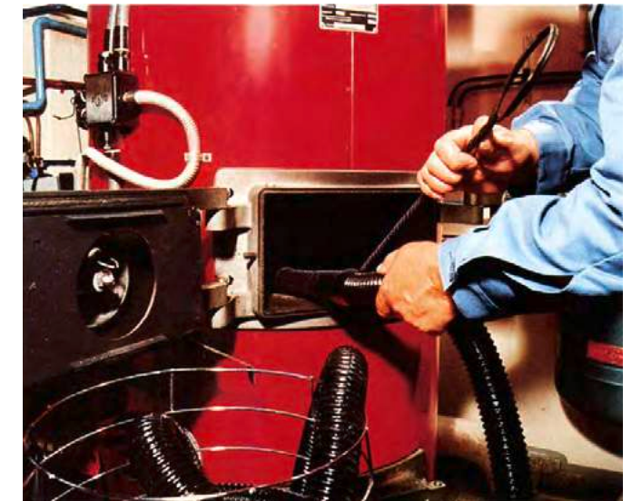
Kesselreinigung Rußbelag erhöht den Brennstoffverbrauch
