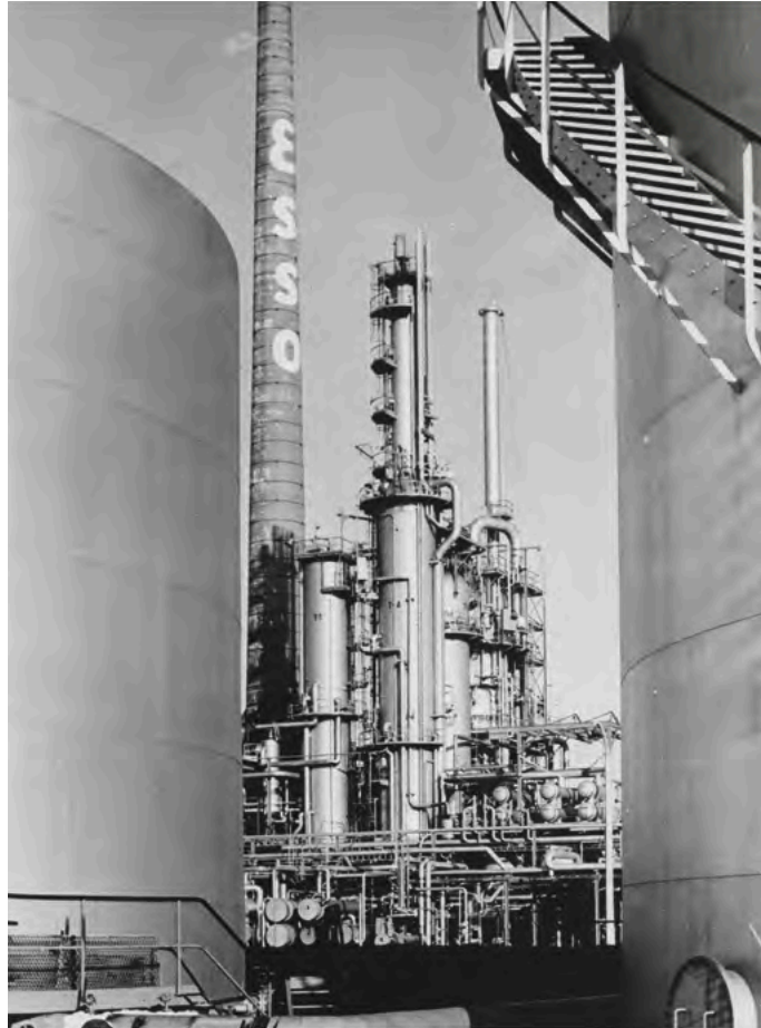
Die neue Katalytische Crackanlage der erweiterten Esso Raffinerie Hamburg
