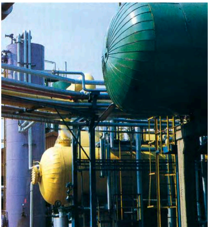
Die Verringerung des Schwefelgehaltes im Dieselmotorkraftstoff und leichtem Heizöl um 40 Prozent auf 0,3 Prozent erforderte den Neubau von Entschwefelungsanlagen
