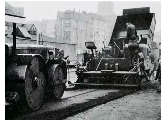
Straßenbau mit Bitumen
