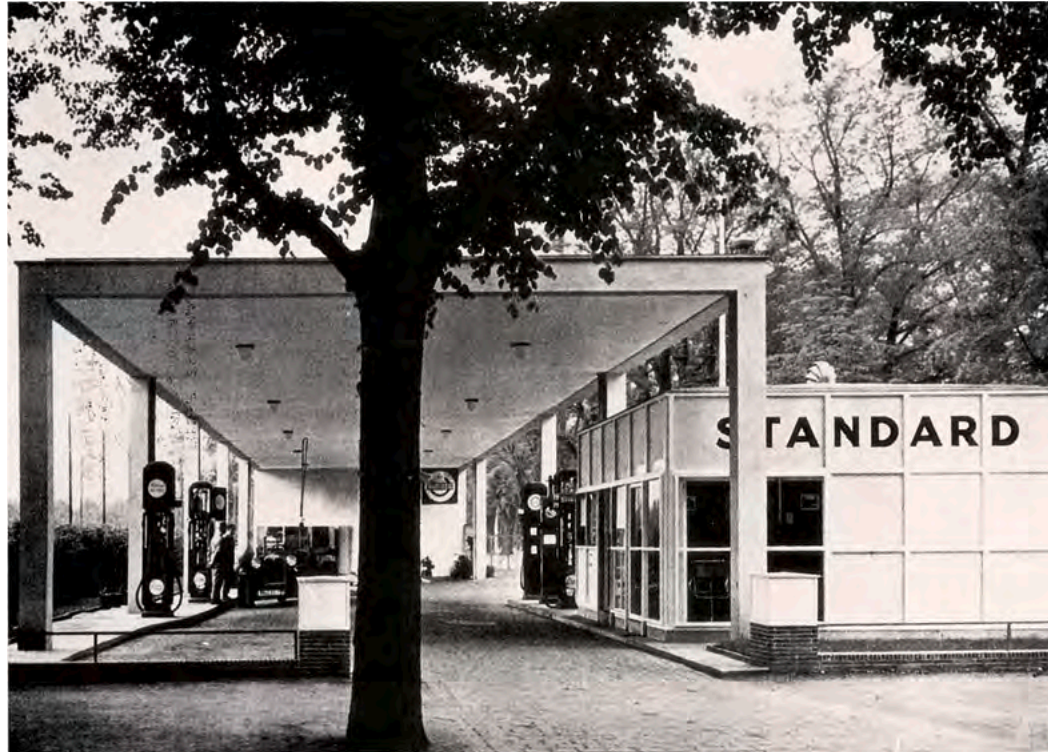
DAPG-Station im Bauhaus-Stil des Hamburger Architekten Karl Schneider
