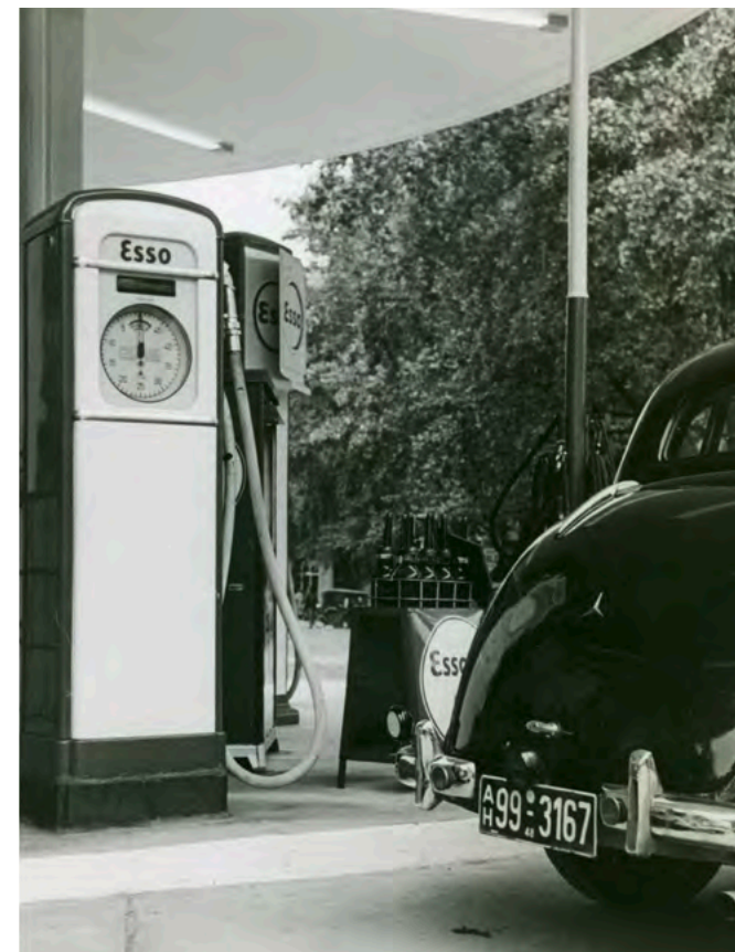
Neue elektrisch betriebene Zapfsäulen
