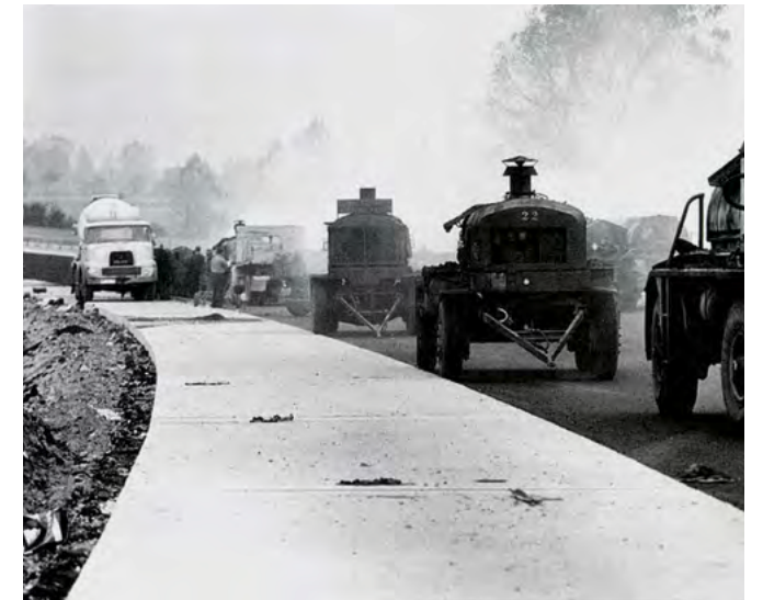
Straßenbau mit Bitumen
