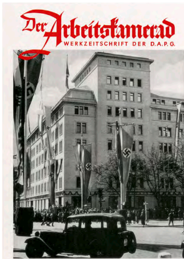
Das erweiterte Esso Haus wurde 1938 bezogen. Der Turm mußte als Plattform für Flakgeschütze eingeplant werden.
