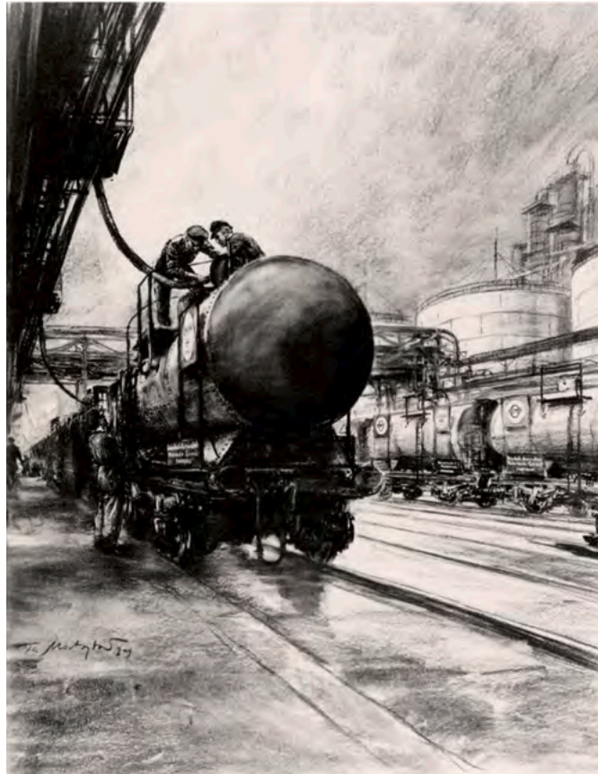
Befüllung von Eisenbahnkesselwagen in der Ebano Raffinerie
