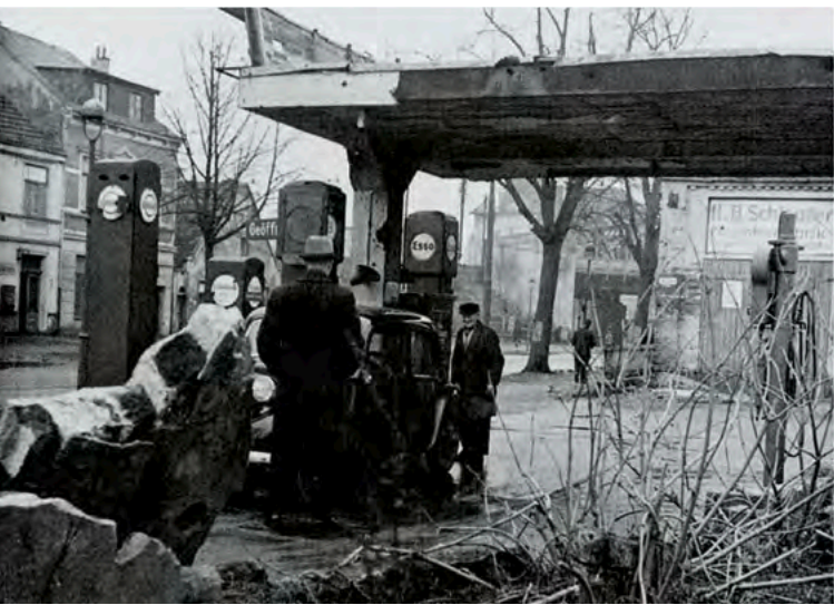
Kriegsschäden an Tankstellen (oben und unten)
