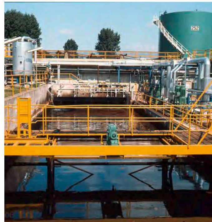
Abwasser-Reinigungsanlage in der Esso Raffinerie Hamburg
