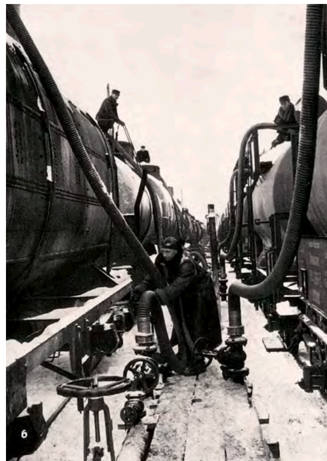
Mineralölumschlag von russischen in deutsche Eisenbahnkesselwagen
