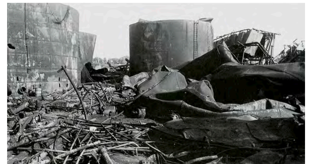
Zerstörte Tanks eines Mineralöllagers
