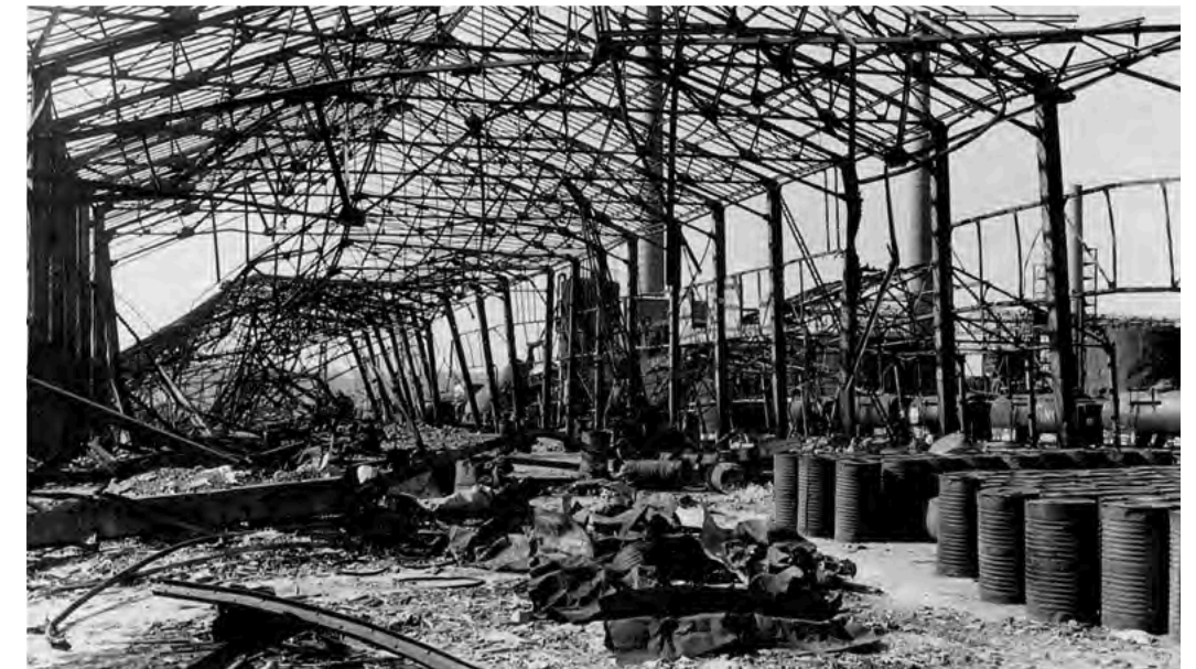
Zerstörte Bitumen-Lagerhalle der Ebano Raffinerie in Hamburg
