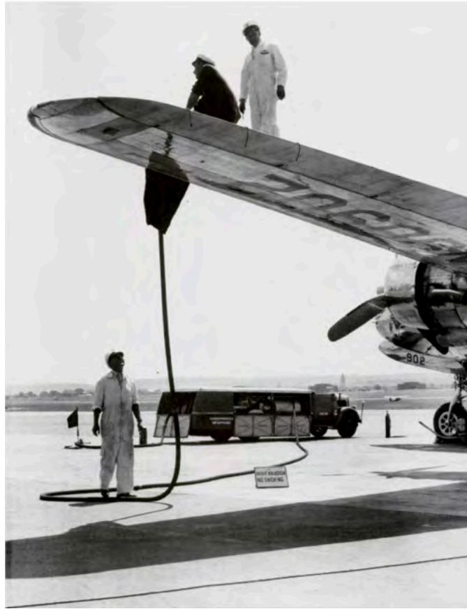
Flugzeugbetankung über Hydrantensystem
