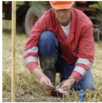
▲ Anschluss des Zündkabels
